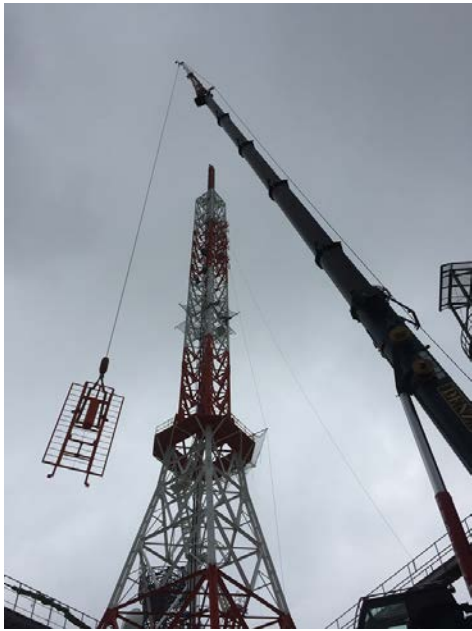
写真4. クレーン吊り上げ作業①
