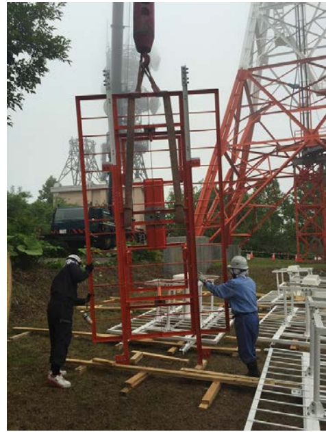
写真5. クレーン吊り上げ作業②
